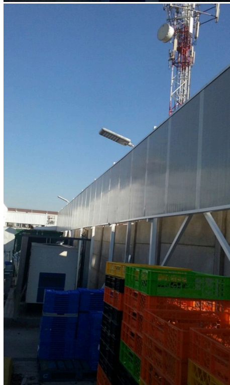
Ilustración 3: Pantalla Acústica sobre muralla perimetral.
