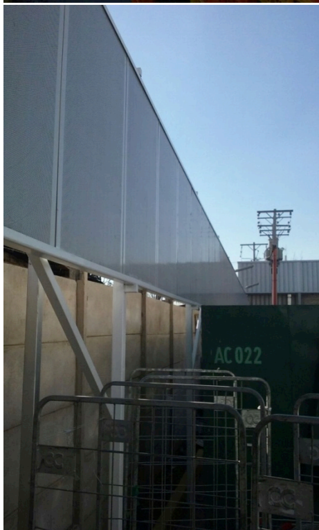
Ilustración 3: Pantalla Acústica sobre muralla perimetral.
