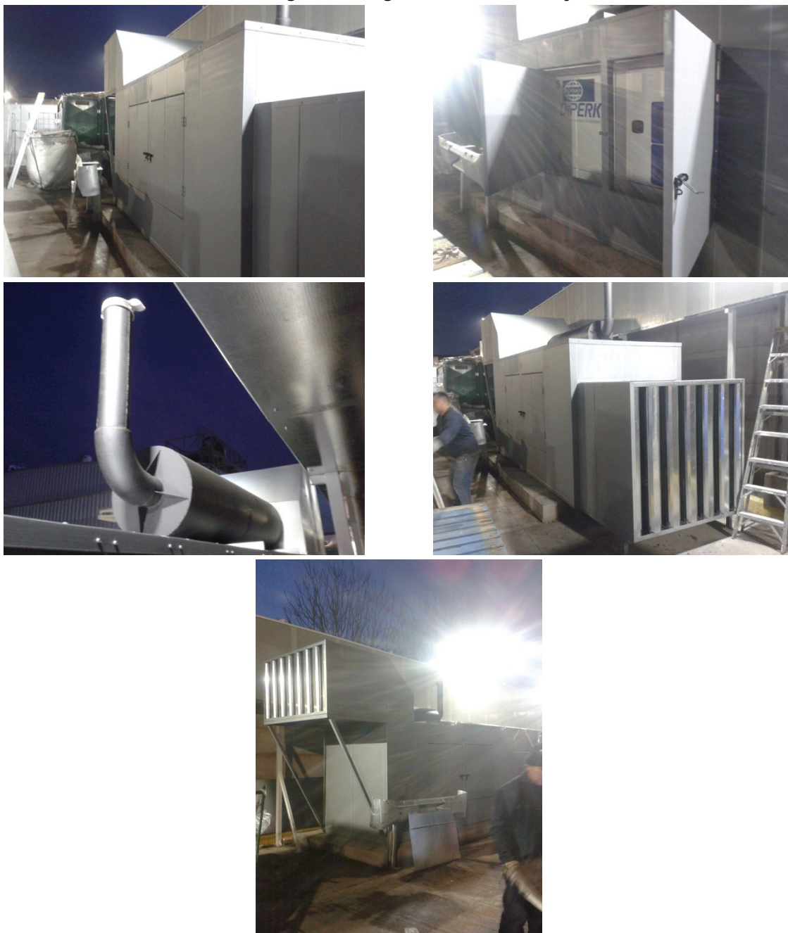
Ilustración 2: Cabina Insonorizada, Silenciadores Splitter de admisión y descarga de aire y silenciadores de escape de gases.
